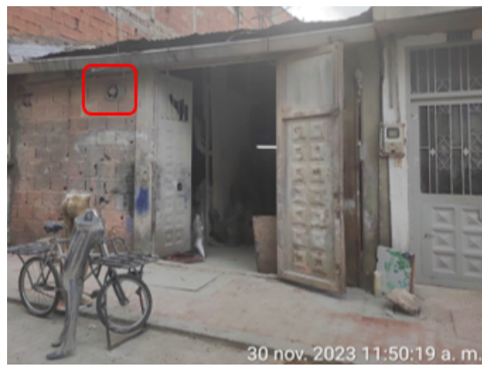
Fotografía 6. Extractor del área de pintura
